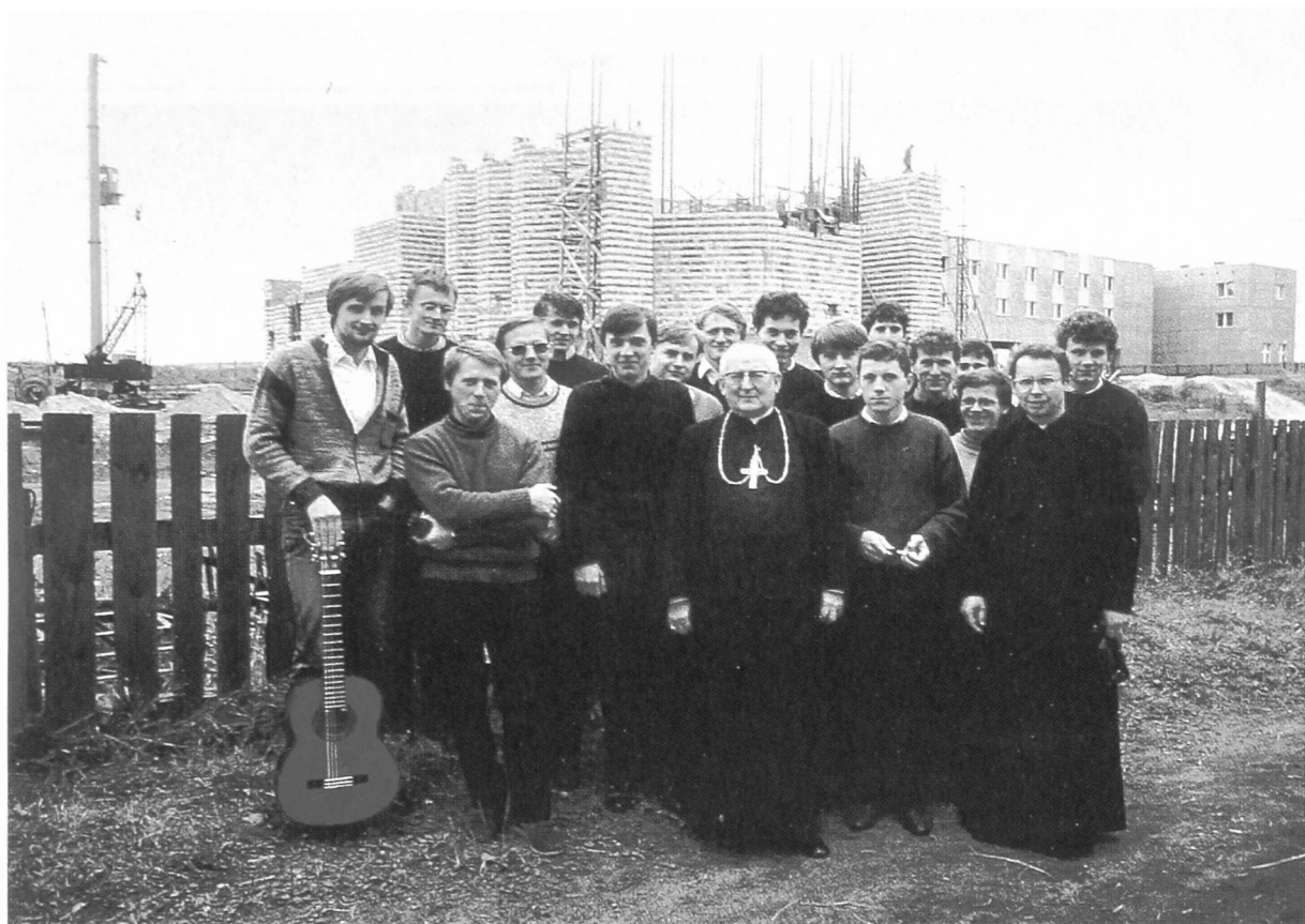
Koszalin-Wilkowo, wrzesień 1986. Na budowie Wyższego Seminarium Duchownego z klerykami i rektorem ks. Marianem Suboczem
